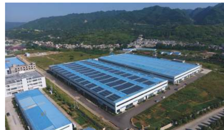
房县 湖北星源科技有限公司厂房
